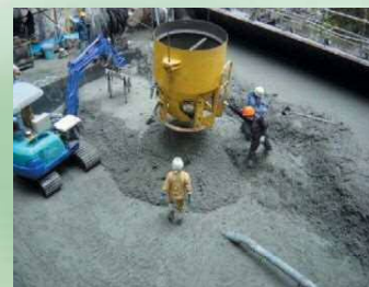
現場打設コンクリート構造物
