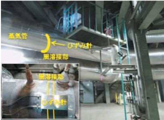
↑蒸気管溶接部へ取り付けたいずみ計
