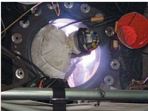
▶蒸気止弁のき裂補修
