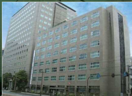
本社小町構内の3号館(写真右)
