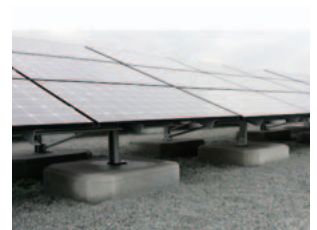
太陽光発電所基礎ブロック
