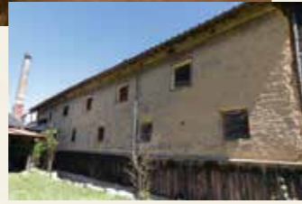
西日本豪雨では蔵が浸水被害に遭ったが、ボランティアの力を借り復旧
