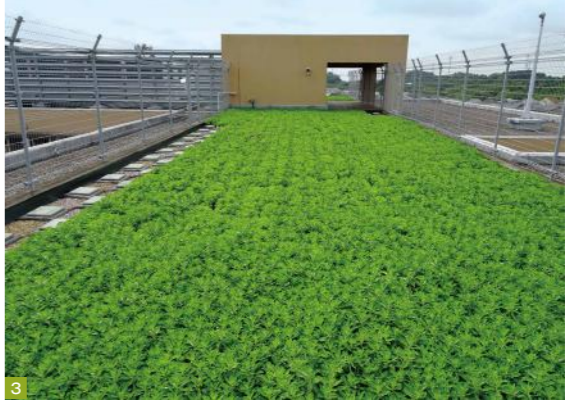
1 特許を取得した常緑キリンソウ袋方式®は、50cm×50cmの不織布製の袋に8kg(乾燥時。含水時は13kg)の専用培土を充填したもの。ファスナーを開けて1袋につき6本の常緑キリンソウの苗を植え入れる 2 常緑キリンソウ袋方式®を置き、苗を植えれば設置完了。押さえ金物などが不要で、簡単に設置できる 3 株が成長し、茎から芽が生えて隙間がないほど成長した常緑キリンソウ 写真提供 / 株式会社フジタ
