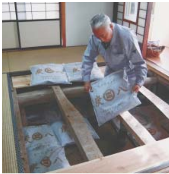
床下に敷き詰めることで快適な居住空間が得られる。写真提供：出雲土建
