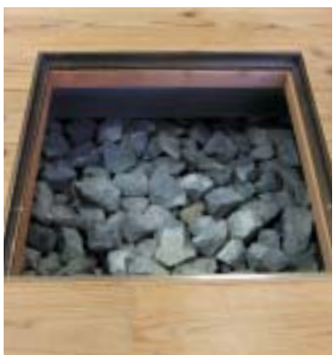
床下に敷き詰める「グリ石」
