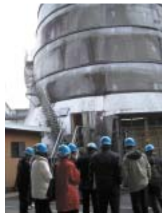
木くずを活用した木質バイオマス発電施設
