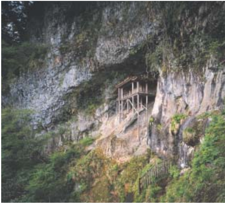
絶壁のくぼみに建てられ、参拝者を寄せ付けない投入堂
