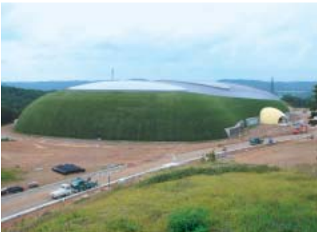
E-ソイルを使った兵庫県立三木総合防災公園のビーンズドーム
