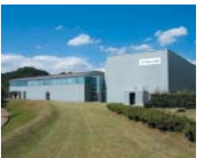
広島中央サイエンスパーク内の本社ビル
