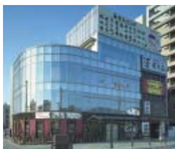
顧客の資産有効活用として建設した広島市の駅前ビル
