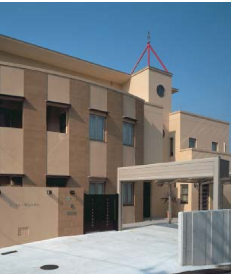
外断熱工法を導入した建物
