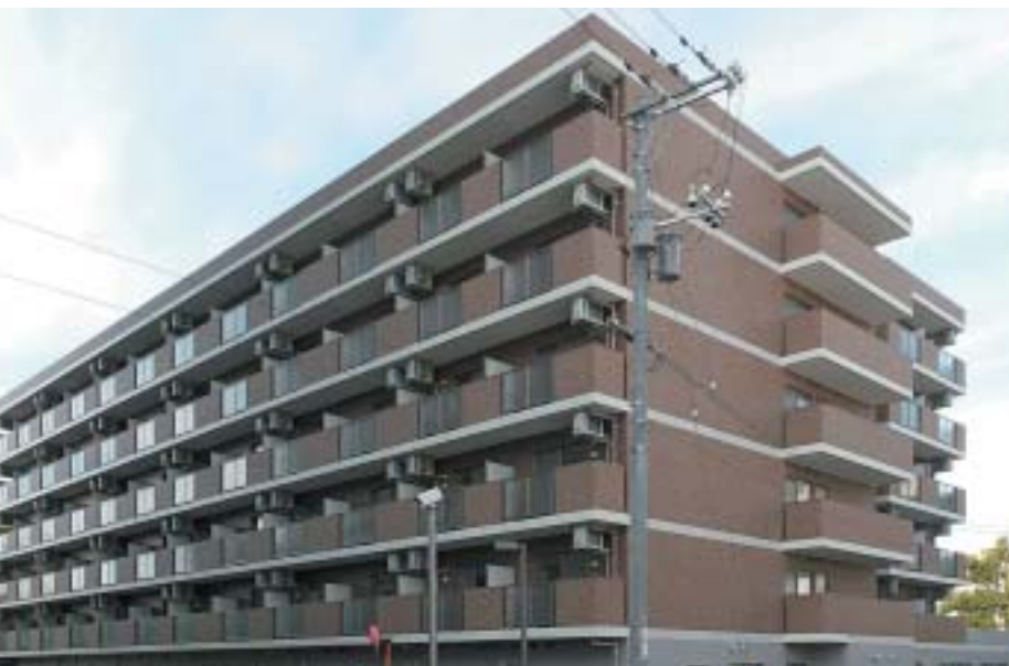
サービス付き高齢者向け住宅Cアミュー「東古松」の外観
