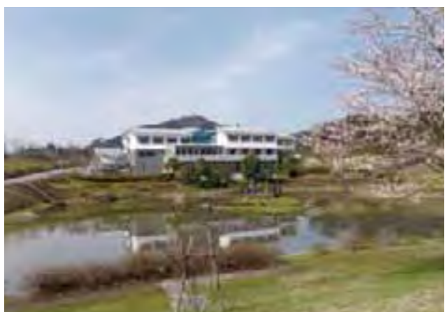
バイオマスボイラーを導入している江津市桜江町の「風の国」
