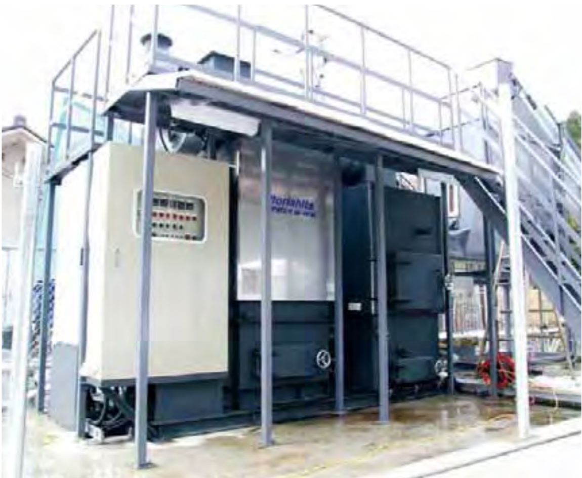
全自動化を実現したバイオマスボイラー
