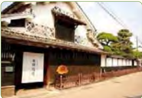
旧商家が建ち並ぶ平田の木綿街道（写真提供：出雲市）
