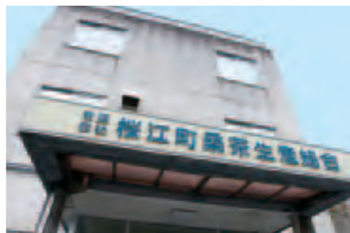
繊維会社の建物を再利用した社屋
