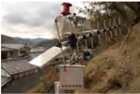
ワイヤーが切れると無線で通信し、サイレンと回転灯が反応する 写真提供:シンク・フジイ
