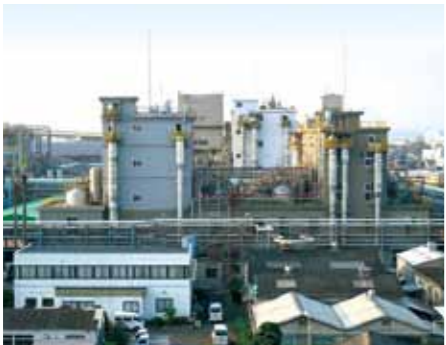
宇部ケミカル工場内のナイロン樹脂工場 写真提供:宇部興産株式会社
