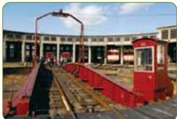
旧津山扇形機関車庫
