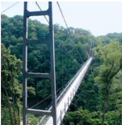
舌震の恋吊橋 写真提供:奥出雲町
