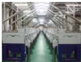
タイの精米工場に導入されたサタケの精米機
