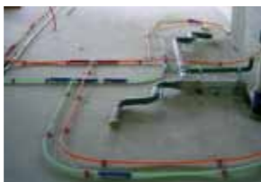
分岐工法敷設状態 写真提供：株式会社カワトP.C.
