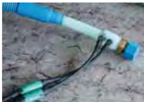
電気融着でパイプと継手を接続
