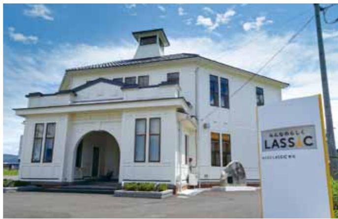
解体危機にあった旧鳥取高等農業学校校舎を改修し、本社として活用
