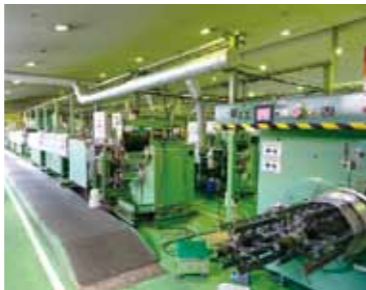
原料から原糸を製造する紡糸設備
