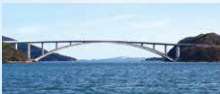
鹿久居島と頭島を結ぶ頭島大橋 写真提供：大生汽船株式会社
