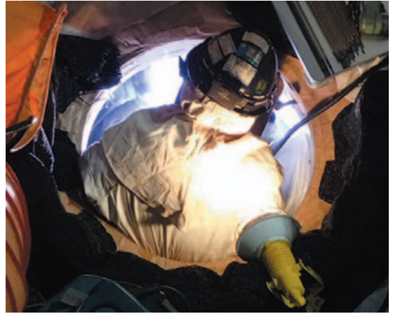
図6 蒸気止弁のき裂補修
