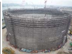
水島基地2号タンク増設工事 (2008年11月)
