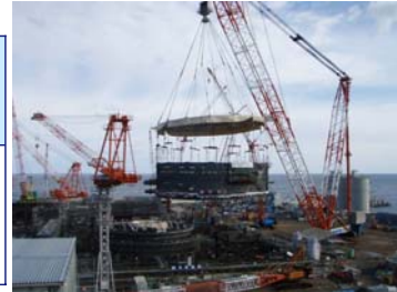
島根3号機建設工事の様子(2008年9月)
