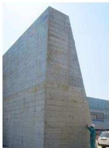
コンクリート打設後の防波壁
