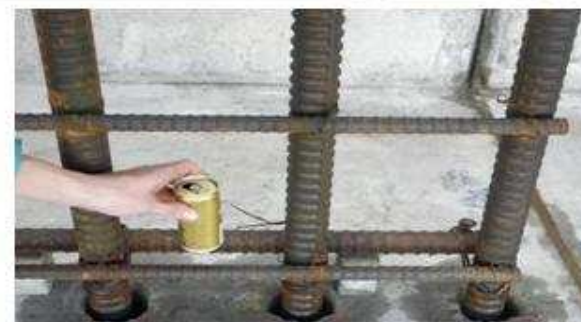
鉄筋は最大で直径51mmのものを使用
