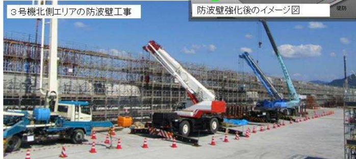
コンクリート打設後の防波壁
