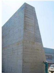
コンクリート打設後の防波壁
