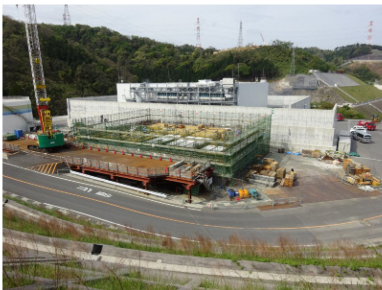
緊急時対策所の設置 (2017年4月時点)
