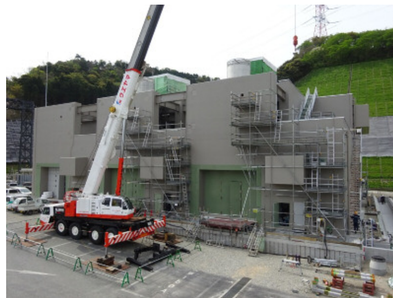
ガスタービン発電機の設置 (2017年4月時点)
