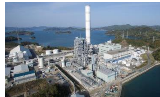
〔実証試験設備の様子〕
