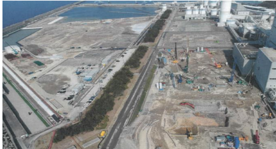
〔建設状況 (2019年2月時点) 〕
