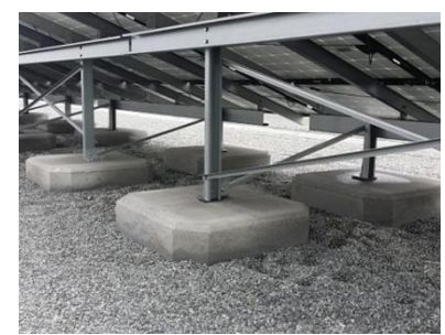
特殊混和材を用いたコンクリート (CO 2 -SUICOM)
