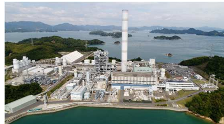
実証試験設備の様子（広島県大崎上島町）
