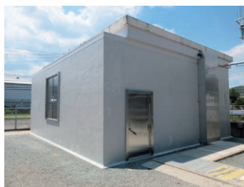
[変電所浸水防止対策(水密化)]
