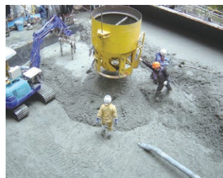
現場打設コンクリート構造物
