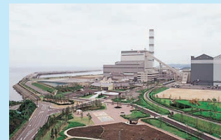
三隰発電所(火力)(1998年)
