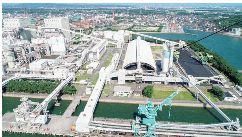
新小野田発電所
