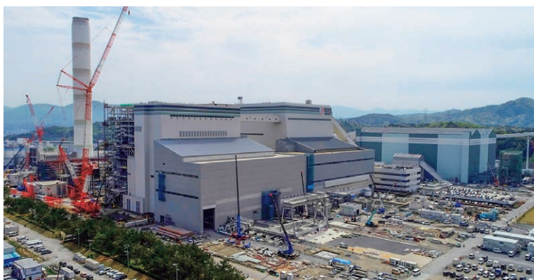
三隅発電所2号機建設工事の様子
