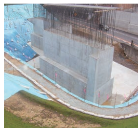
浜田三隅道路 跨道橋におけるコンクリート混和材 (エコパウダー)
