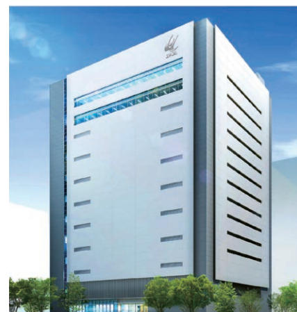
広島データセンター
