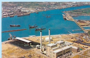
水島発電所(火力)(1961年)
