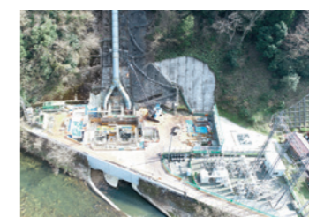
北原発電所の改修工事 (発電所出力:15,600kW→17,700kW)
