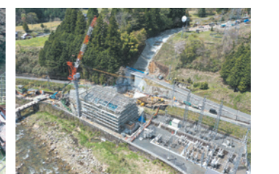
奥津発電所の改修工事 (発電所出力:7,400kW→7,500kW)
