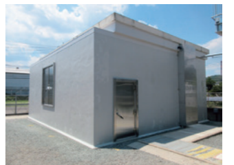
〔変電所浸水防止対策〕(水密化)
