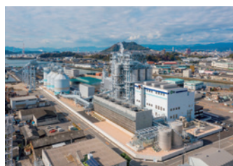
国内最大規模のバイオマス混焼発電所である海田発電所
