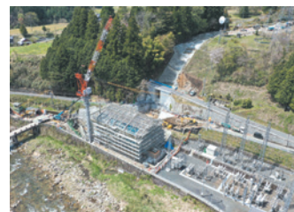
奥津発電所の改修工事 (発電所出力:7,400kW→7,500kW)
