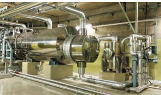
2025年度解体工事着手設備 （ターピングランド蒸気発生器室内）
