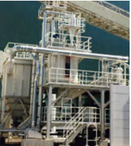
回収した粉じんを再度ペレット化し燃料として再利用する再造粒設備
