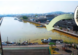
福山港内港（事業実施前：2012年5月）
