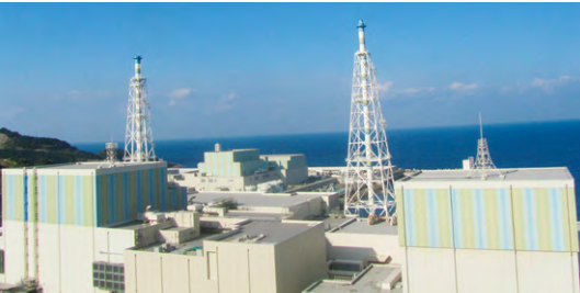
島根原子力発電所
