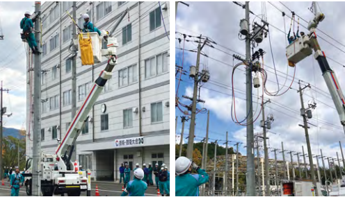
技術・技能大会(配電関係)
