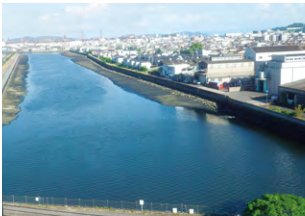
福山港内港（事業実施後：2023年8月）
