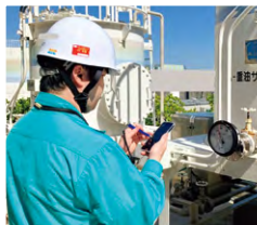
巡視点検風景
