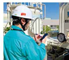
巡視点検風景
