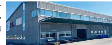
配電機材リユースセンター
