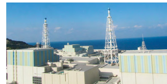
島根原子力発電所
