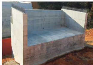
大田静間道路跨道橋における コンクリート混和材（エコパウダー）
