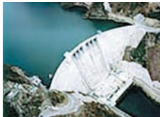
新成羽川発電所(水力)
