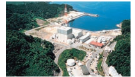
島根原子力発電所1号機
