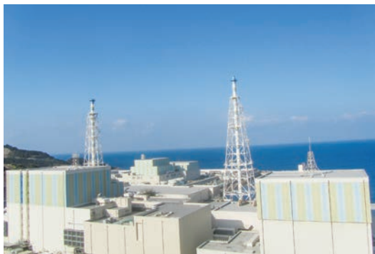
島根原子力発電所
