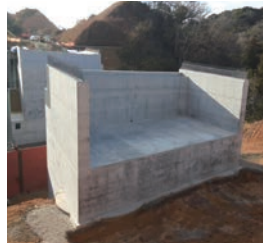
大田静間道路 跨道橋における コンクリート混和材 (エコパウダー)
