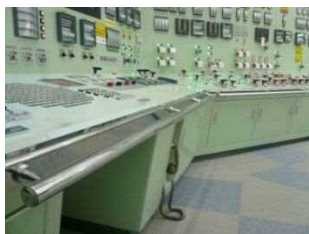
手摺設置状況
