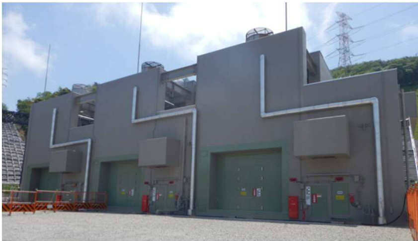
<ガスタービン発電機建物外観>
