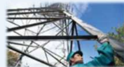
《送電設備の巡視・点検》
