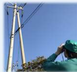
《配電設備の巡視・点検》
