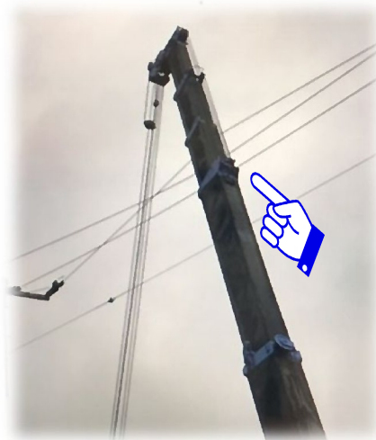
<クレーンが電線に接触>
