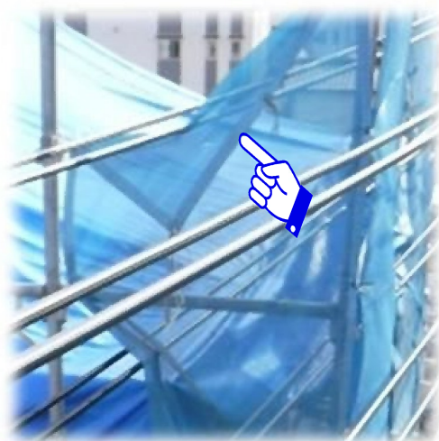
<足場が高圧電線の間を貫通> <足場が高圧電線に接触>
