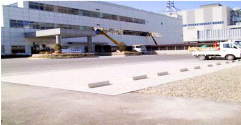
写真3 大崎発電所お客様駐車場の施工状況
