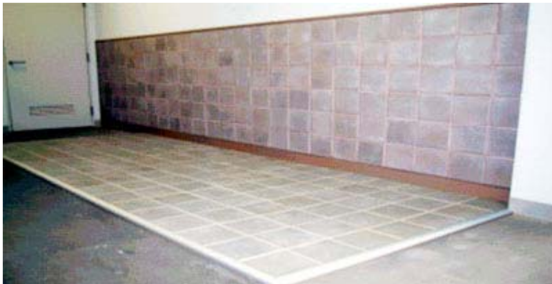
写真4 技術研究センター屋内の施工状況
