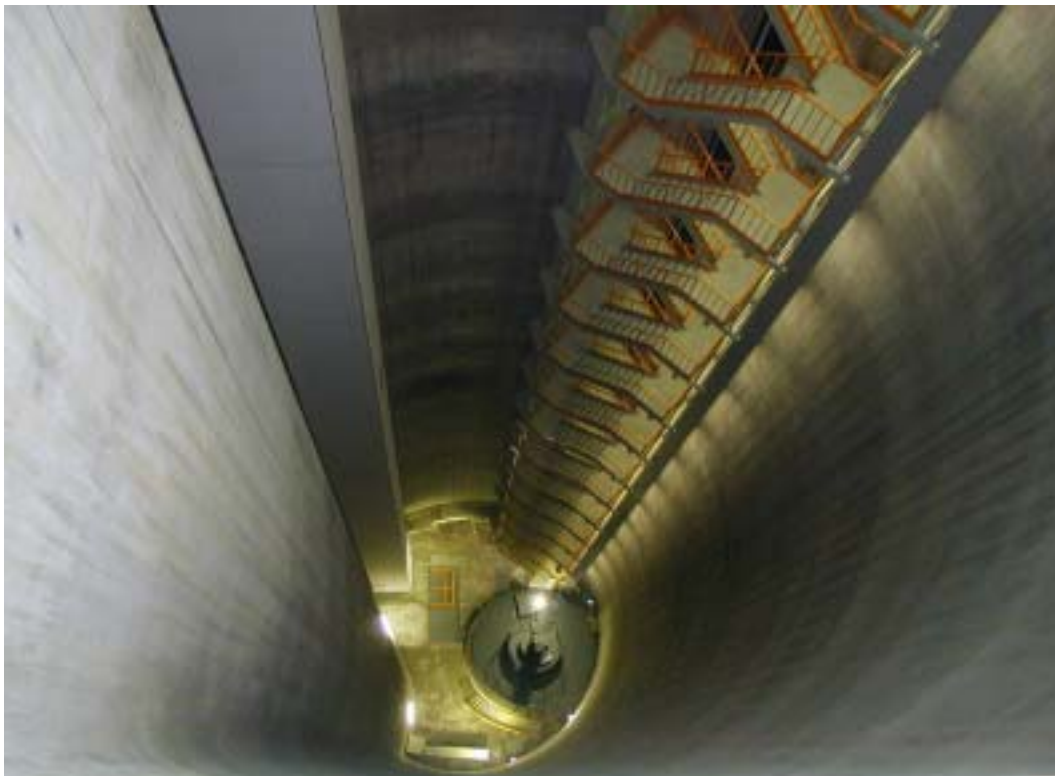
奥津第二発電所立坑(深さ 75.9m)を上部から望む
