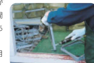
電力量計の点検・修理
