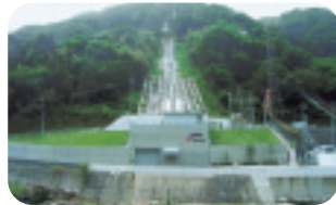
2006年6月に営業運転を開始した新帝釈川発電所
