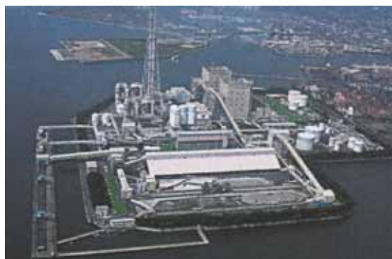
【新小野田発電所（山口県）】
