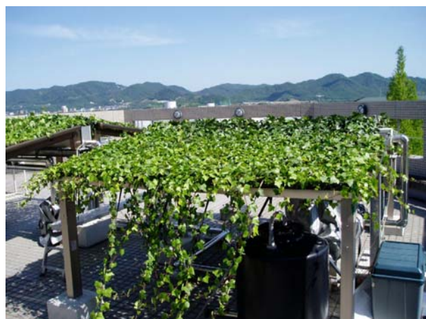
写真3：実証試験装置全景（2007年8月）
