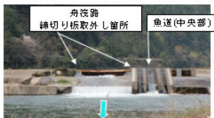
取水えん堤中央部放流設備 状況写真
