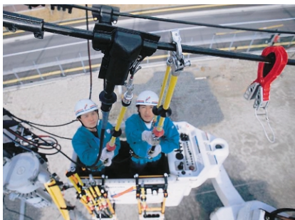
▲間接活線工法による作業風景
