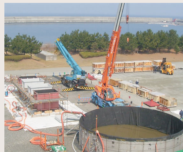
脱硝触媒の洗浄作業
