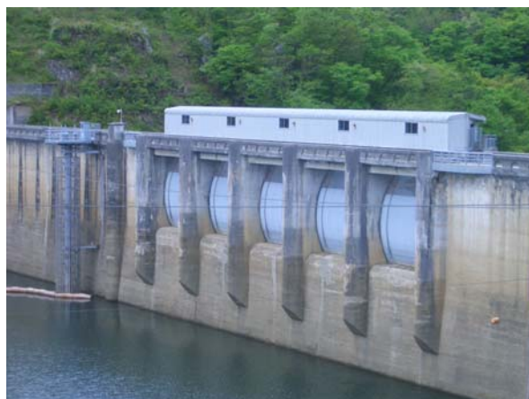
【ダム洪水吐ゲート(上流面)】
