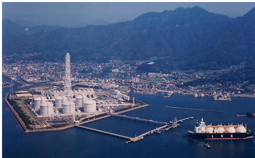
柳井LNG基地の概要 ・設備：LNGタンク 8万kl×6基 ・年間取扱数量：150万 t 程度
