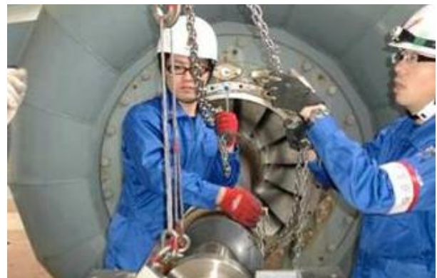
【作業を通じた技術・技能継承[水車発電機点検]】
