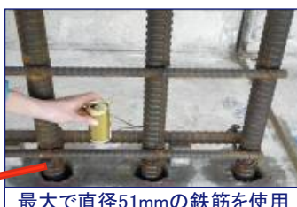
最大で直径51mmの鉄筋を使用
