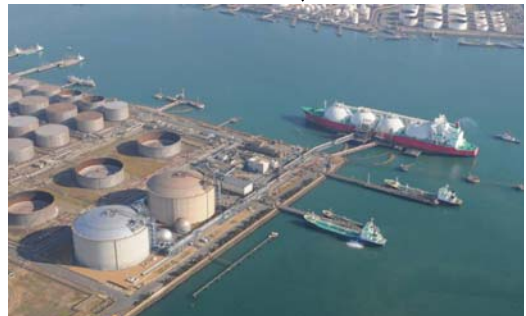
水島LNG基地の概要 ・設備：LNGタンク 16万kl×2基 ・年間取扱数量：100万 t 程度 岡山パイプラインの概要 水島基地～岡山市内 (直線距離約30km) ・輸送能力：35万 t/年程度
