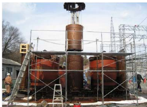
【変圧器コイルの劣化調査の様子】
