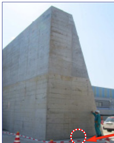
【コンクリート打設後の防波壁(3号機北側エリア)】
