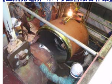
【三隅発電所 ボイラ配管取替作業】
