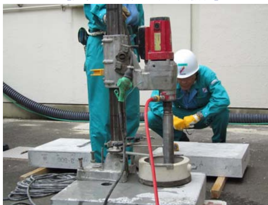
【建物天井を開口する資機材】
